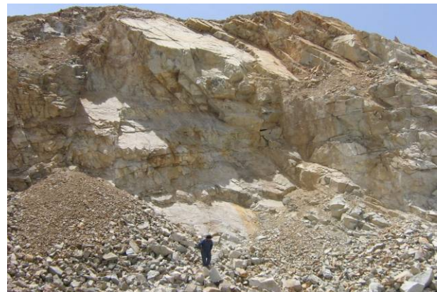
تصویر ۹- پتانسیل لغزش گوه‌ای بلوک B2 در راستای شکستگی‌های J1 و J5 در دیواره غربی معدن
