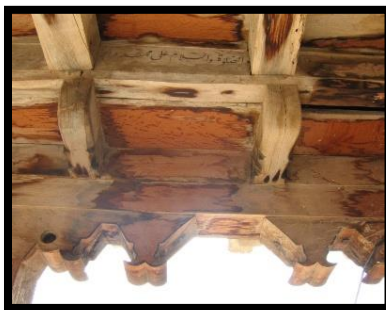
تصویر ۷. تزئینات خارجی و داخلی بنا برج مقبره‌ی طاهر و مطهر (نگارنده، ۱۳۹۹).
