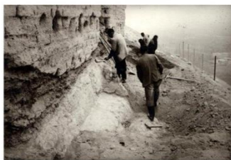
قسمتی از تخته سنگ گوه که تراشیده شده و در حین خاکبرداری جهت مرمت مشخص شد
