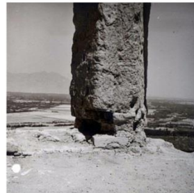
یکی از پایه های ساختمانی که بعدا ساخته شد
