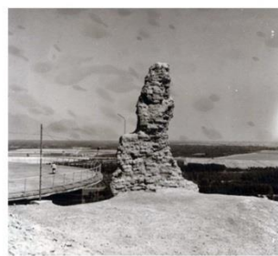
چگونگی بریده شدن تپه برای تعبیه منبع آب و صدمه ای که به بنا وارد نموده است
