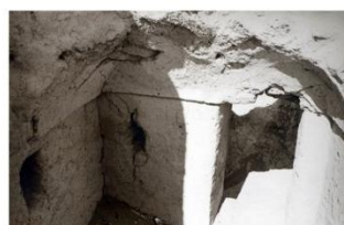
ترمیمه یکی از اطاقهای باقیمانده در شمال شرقی بنا
