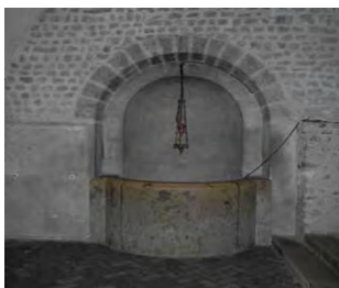
(شکل ۶) چاه آب، تعمیرگاه کلیسای شارتر- فرانسه. (جوادی، ۱۳۹۳، ۴۴)
