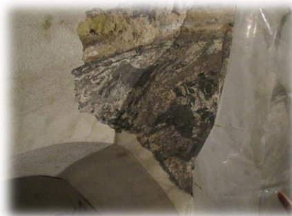
باقیمانده گچ بری سقف (تحت مرمت)
