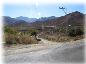
مسیر فرعی از جاده اصلی به سمت سد
