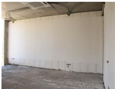
شکل ۱۳- اجرای پانل کامپوزیت به عنوان دیوار داخلی [۱۲]
