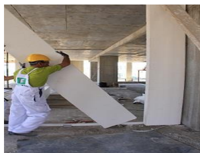
شکل ۱۲- نصب سریع در اجرای پانل‌ها [۱۲]
