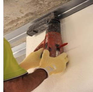
شکل ۱۶- نحوه مهار پانل به سقف [۱۲]
