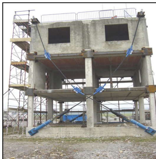
شکل ۱. ساختمان بتنی مهار شده با کابل بصورت خارجی
