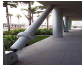
شکل ۲-ب-نمایی از میراگر نصب شده مرکز دارویی Arrowhead Regional Medical Center
