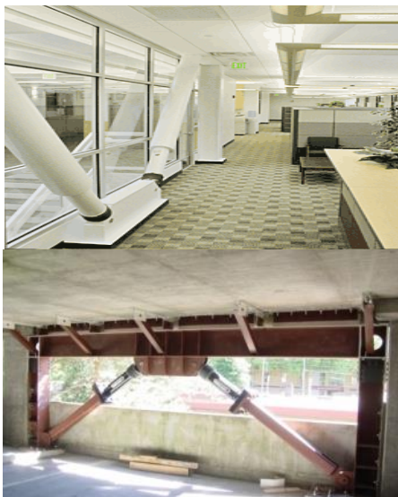
شکل (۲) چند نوع میراگر ویسکوز ساخته شده توسط شرکت تیلور [۵]
