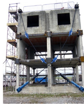
شکل ۱- ساختمان بتنی مهار شده با کابل که توسط شرکت جرت ساخته شده است
