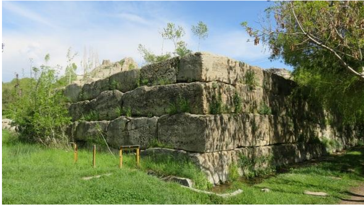
تصویر ۳: دیوارهای قلعه سادوربورچ در مجموعه قلاع وان
