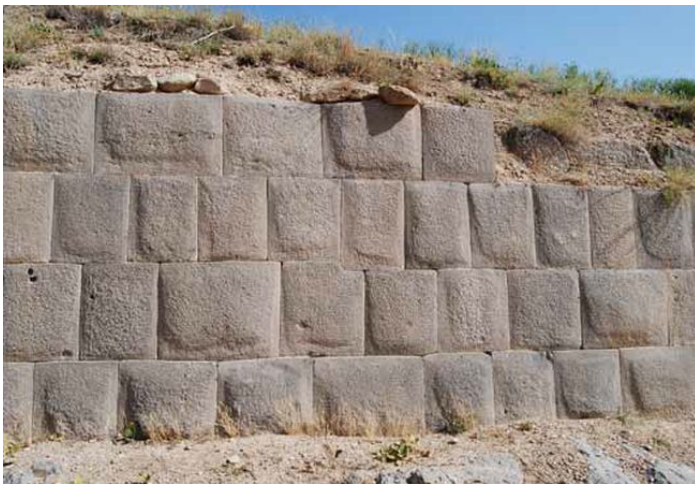
تصویر ۴: حصار سنگی متشکل از بلوک های ۳ یا ۴ متری، قلعه مادربورچ
