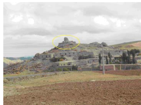
تصویر شماره ۱۳: قلعه ورمزیار (دوره سلجوقی) و خانه های اطراف آن.
