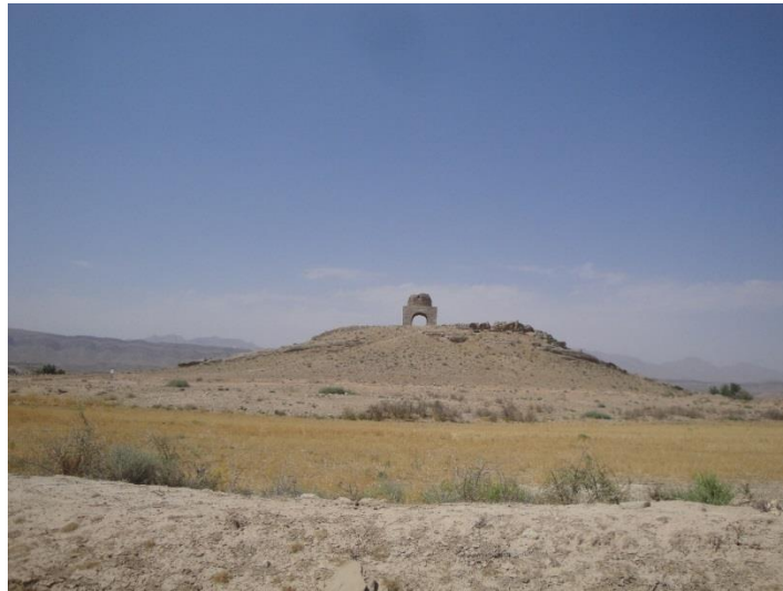
تصویر ۳: چهارطاقی باباعرب (دید از شرق)
