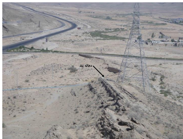
تصویر ۸: بند و بست ۱، نمای کلی (دید از جنوب شرق)
