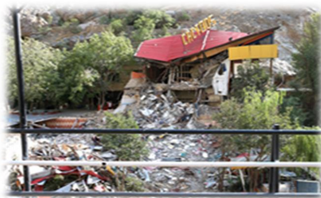
شکل ۳ - تخریب رستوران در حاشیه رودخانه کن بر اثر سیل
