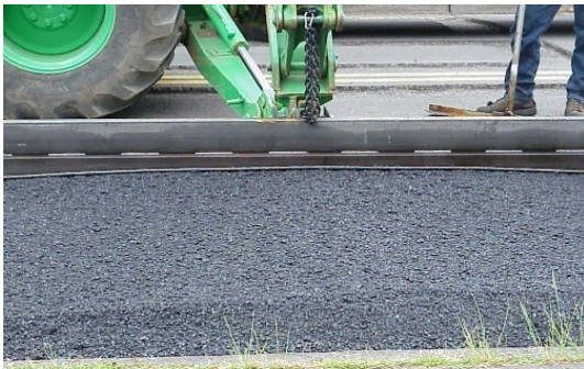
شکل ۳۵- روش ساخت سرعت‌کاه‌ها با شابلون
