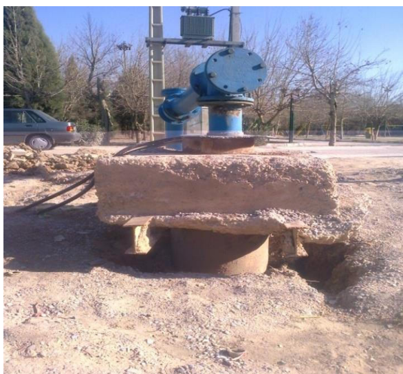
شکل ۱۴- بالا آمدگی لوله های جدار چاهی در روستای
