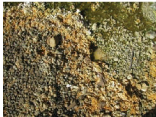
شکل ۲- قسمتی از شن زهکش سازه فرو شویی شماره ۲ معدن سرچشمه
