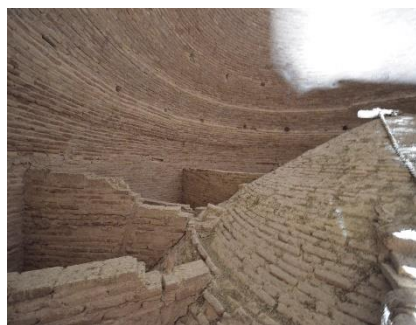
تصویر ۱۰ و ۱۱ و ۱۲ گنبد دو پوسته کلیسای بیت‌لحم و جزئیات اجرایی. منبع: (نگارندگان ۱۴۰۱).
