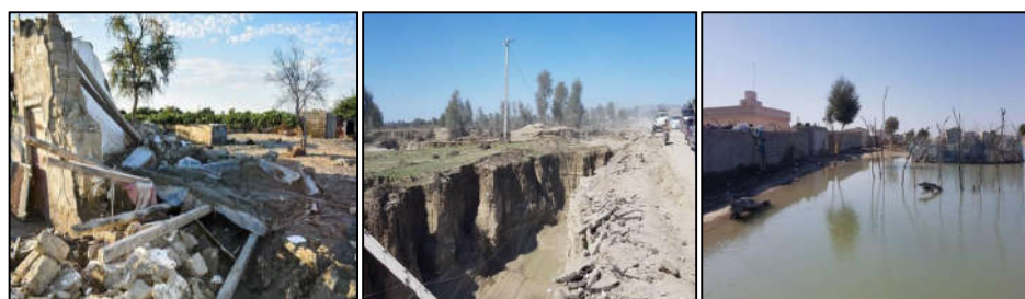
تخریب خانه‌ها در منطقه سیل زده
