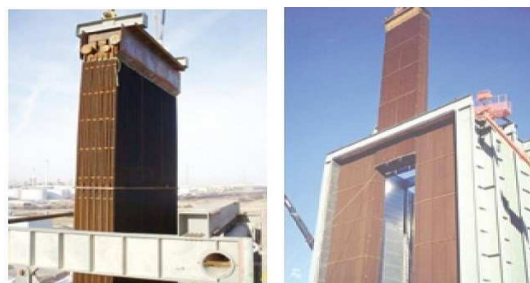
Fig. 2. Finned tubes position of harp modules in HRSG [5].
