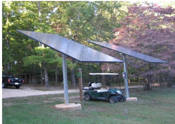
شکل ۲- پانل خورشیدی با قدرت ارایه به ساختمان و چرخ دستی های گلف (منبع: (۵))
