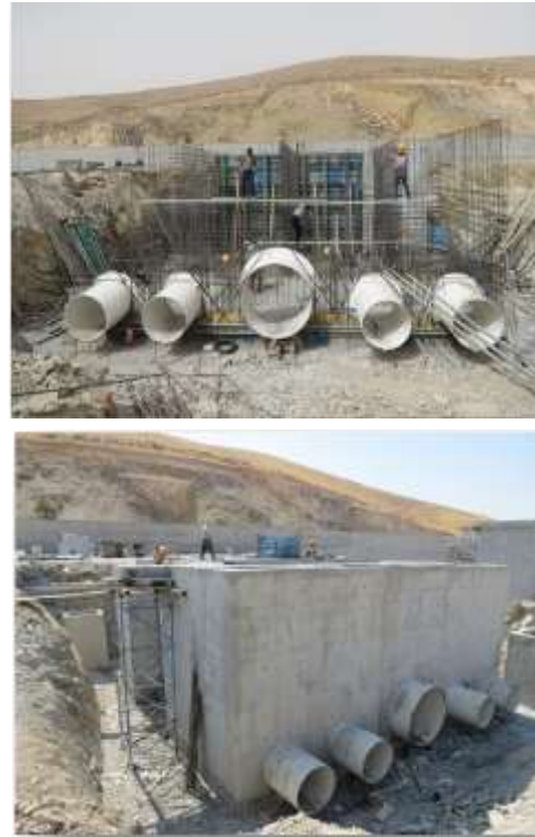
شکل ۴- مراحل ساخت واحد اختلاط سریع
