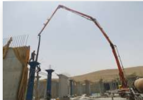
شکل ۱۱- مراحل ساخت مخازن آب
