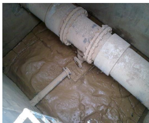
شکل ۲- مشکلات و خسارات طرح مدیریت منابع آب گاوشان (سرقت شیرآلات و شکستگی رایزر و شر خودکار) Figure 2- Problems and losses of the Gawooshan water resource management plan (theft of faucets and breakage of automatic risers and washers)
