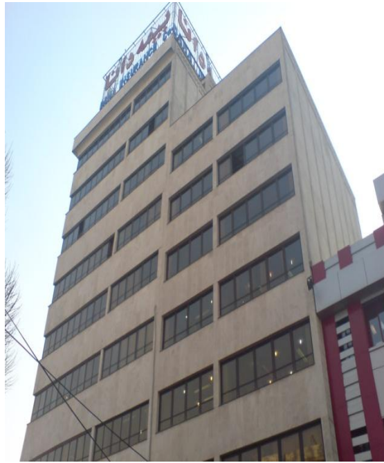
شکل ۲- نمای شمالی ساختمان (۵)
