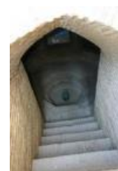
شکل ۷- سرداب خانه مرتاض Figure 7. The cellar of the Mortaz house
