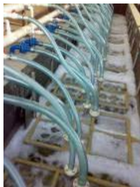
شکل ۲- سیستم MBR جریان مستغرق به منظور تجزیه بیولوژیکی پسماندهای شهری در کشور چین
