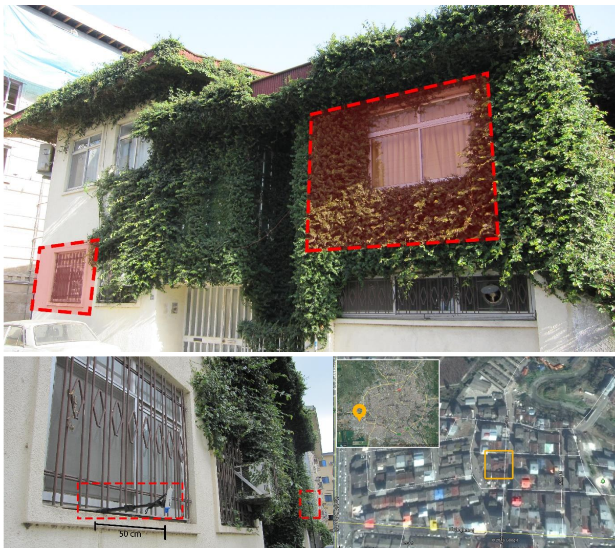
شکل ۲- مشخصات و تصاویر ساختمان منتخب و موقعیت دقیق دیتالاگرها بر روی دیوار
