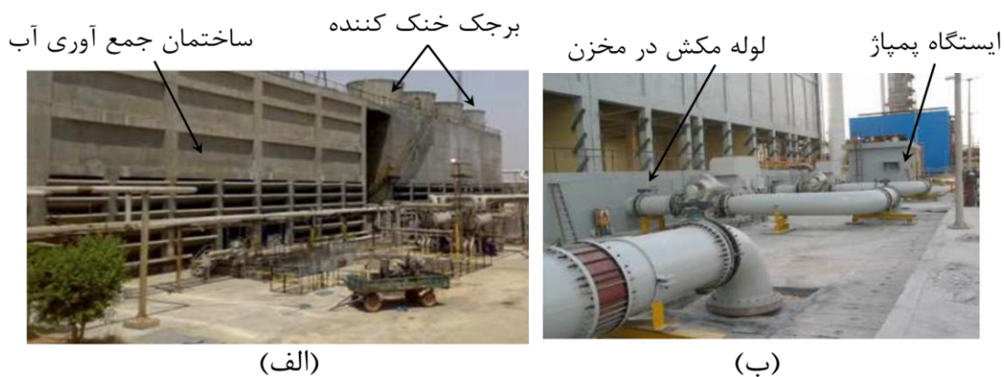
شکل ۳. ساختمان برجک خنک کننده با حوضچه آرامش، (الف) سازه‌ی بتنی نگهدارنده تجهیزات برجک، (ب) تجهیزات پمپاژ آب از انتهای حوضچه آرامش
