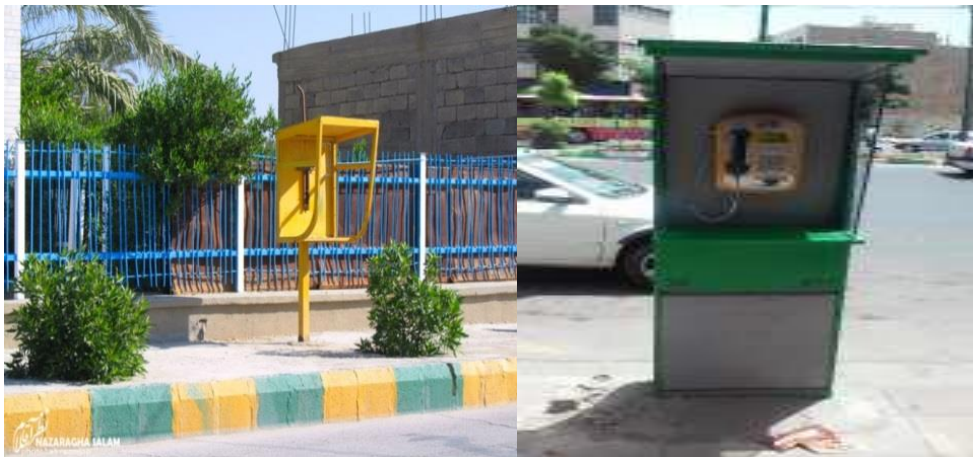
شکل ۵: جانمایی نامناسب و ارتفاع زیاد تلفن از کف باجه
