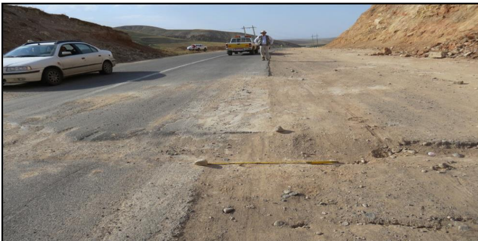
تصویر ۵: گسلش سطحی زمین لرزه اهر - ورزقان با کمینه ۵ سانتی متر جابجایی راستالغز راستبر ۵ سانتی متر شاغولی، جاده اهر (موسسه ژئوفیزیک ایران، ۱۳۹۳).
