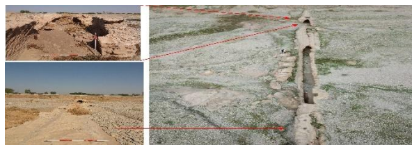
شکل ۱۵: تصاویری از بخش‌های مختلف سیفون شماره دو (سازه شماره: ۱۱) (یعقوب زلقی، ۱۴۰۴).
