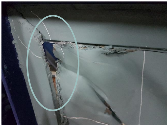
شکل ۲۴ - پارگی و جدشدگی کامل ورق
