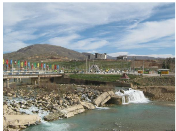
شکل (۳) ایستگاه پل بشار
