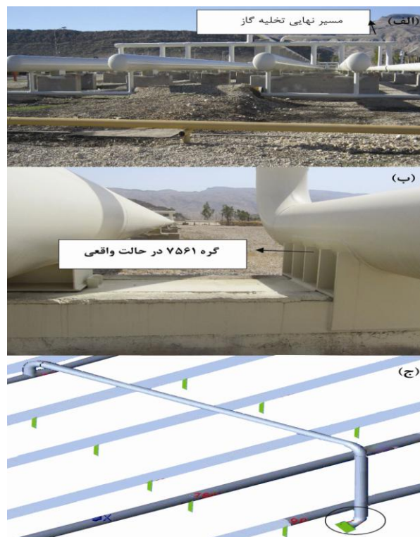
شکل ۸- مسیر تخلیه گاز از لخته گیر و نمایش گره ۷۵۶۱
