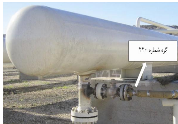
شکل ۱۰- نمایش گره شماره ۲۲۰ (محل اتصال تبدیل ۲×۳ به فلنج گردنی ۲")
