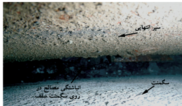
تصویر ۱۰- تجمع مصالح بر روی آخرین سگمنت نصب شده در سقف
