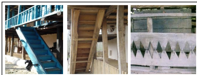
شکل ۴. پله و اتصالات آن (Source: Rural Architectural Heritage of Guilan)
