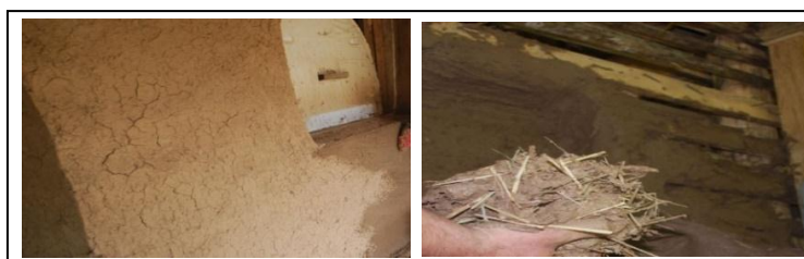
شکل ۸. ملات های ساده و قابل جداسازی در بناها (Source: Rural Architectural Heritage of Guilan)
