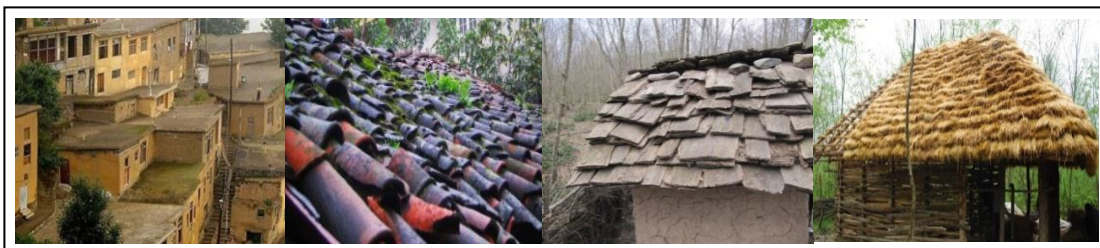
شکل ۱۳. انواع پوشش بام از راست به چپ: بام گولوش پوش، لته سر، سفال و تخت (Source: Rural Architectural Heritage of Guilan)
