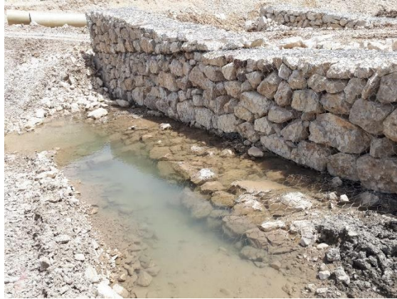
شکل ۴- سازه گابیونی برای دستک آبگذر ۴+۴۰۰
