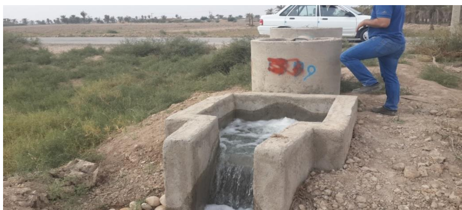
شکل ۵- هدایت آب از حوضچه آبگیر دوقلو به داخل نهر درجه ۴
