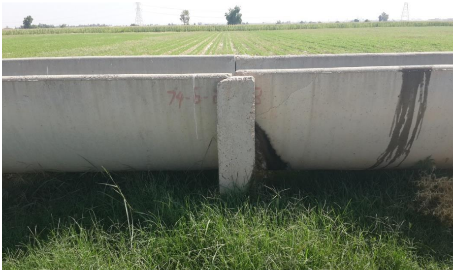
شکل ۴- ریزش آب از کانال و رشد علف‌های هرز
