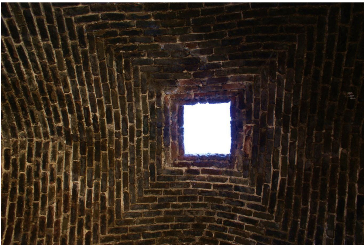
شکل شماره ۷: نورگیر سقف کاروانسرای نیک پی (عکس از نوراللهی)
