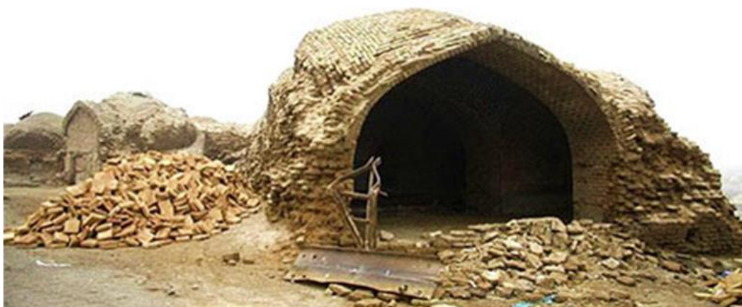
شکل شماره ۳: کاروانسرای نیک پی قبل از مرمت-بخشی از طاق‌های ضلع شمالی (آرشیو میراث فرهنگی زنجان).
