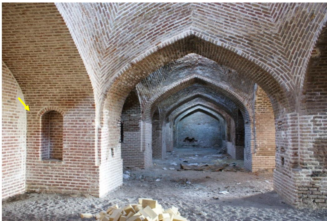
شکل شماره ۹: بخاری های دیواری و قوس و طاق های ضربی کاروانسرای نیک پی (ع. نوراللهی).
