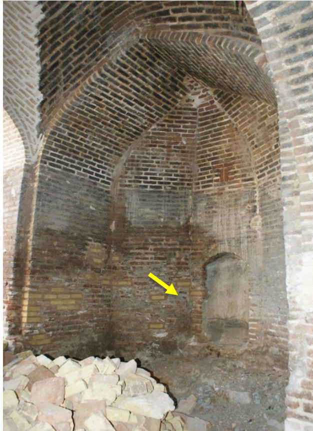
شکل شماره ۱۰: سه کج گوشه حیاط بخاری‌های دیواری و قوس و طاق‌های ضربی کاروانسرای نیک‌پی در کنار ورودی‌ها (ع. نوراللهی).
