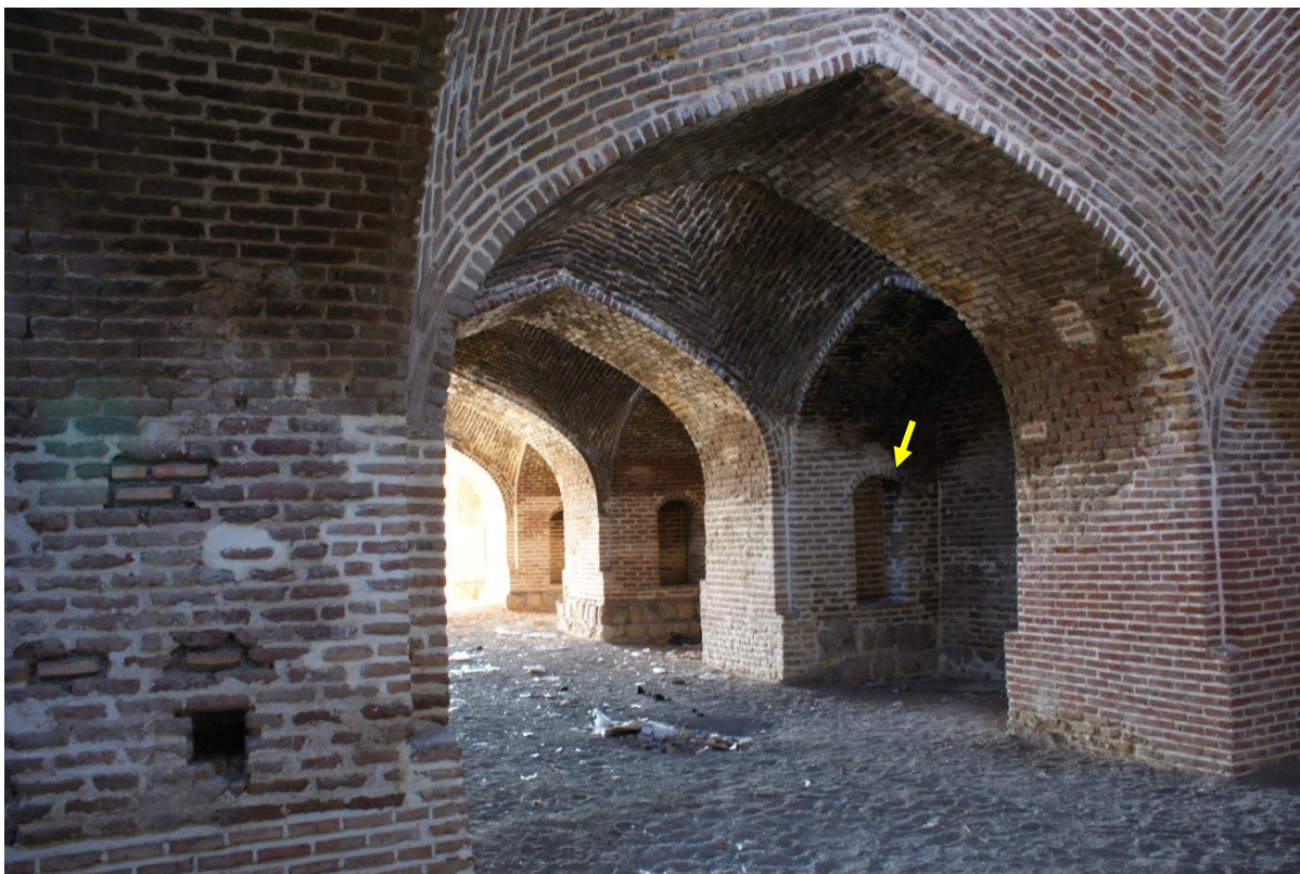
شکل شماره ۸: بخاری های دیواری و طاق های کاروانسرای نیک پی (عکس از نوراللهی)
