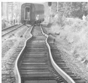
شکل ۱- کج شدن ریل‌های قطار بر اثر گرما [3].
